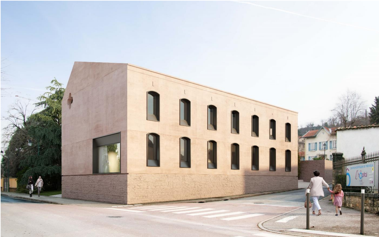
Crédits : AUM - Vue depuis l'accès à l'Hôpital
